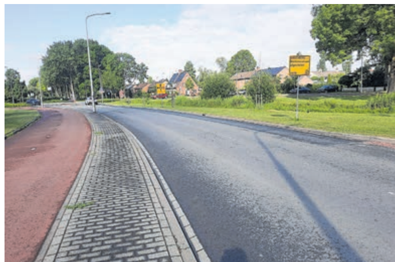
Hortensialaan vanaf de Dreef/Zwarteweg dicht wegens werkzaamheden aan kabels en leidingen. Foto: Redactie Aalsmeer
