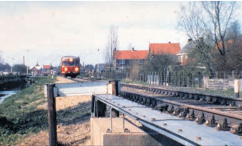
In 1972 passeert een passagierstrein voor de laatste keer de Spoorlaan, op de foto tussen de Ophelialaan en de Mensinglaan. Foto: aangeleverd
