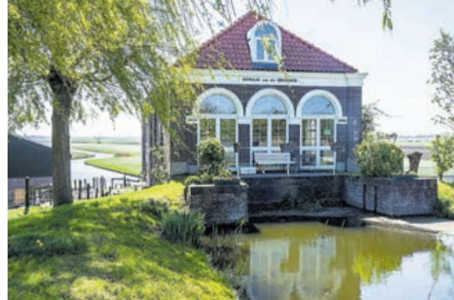
Gemaal bij Bilderdam
