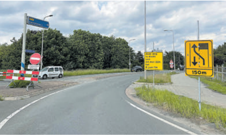
Werkzaamheden op de Legmeerdijk. Foto: Gemeente Aalsmeer
