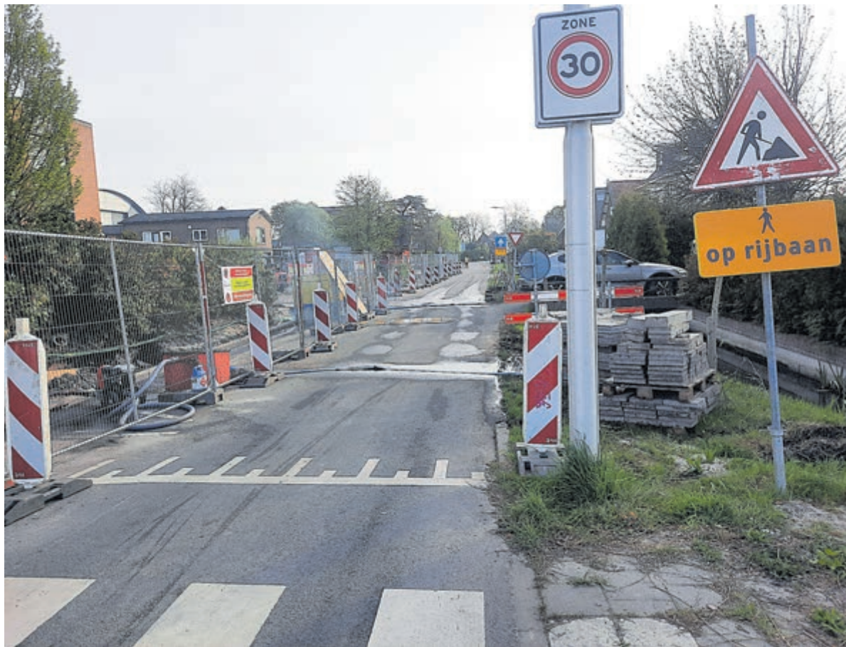
Nieuwe leidingen en kabels in de Dorpsstraat, Lijnbaan en Verlengde Lijnbaan. Daarna volgt herinrichting tot fietsstraten en aanleg van een wandelstrook. Foto: Redactie Aalsmeer
