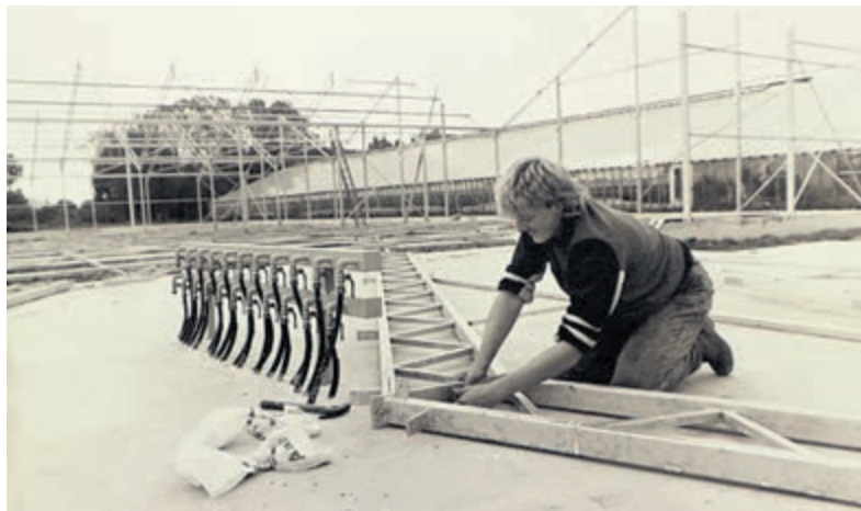
Kassenbouwer aan het werk.
