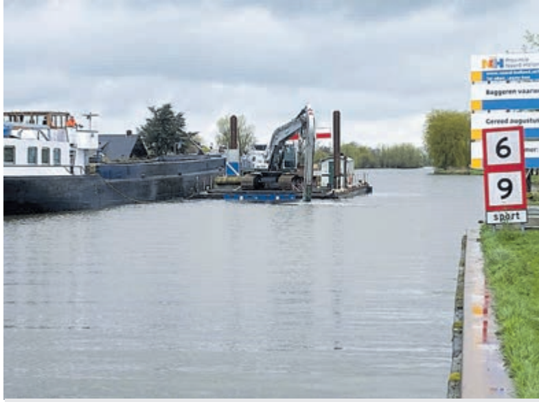
Ponton met kraan en schip waarin bagger wordt verzameld en verscheept. Foto: Provincie Noord-Holland.
