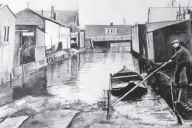
Baggerwerkzaamheden in de Wetering. Door Jan Pannenkoek.
