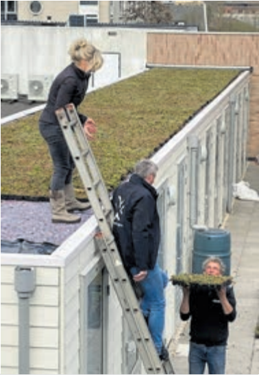
Aanleg sedumdak door bewoners van de Posterijen. Foto: aangeleverd
