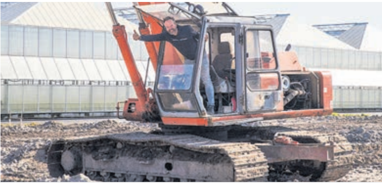
Eerste heipaal door Ard van Van Klaveren Plant. Foto: www.kicksfotos.nl
