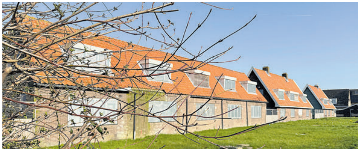
De 12 rijtjeswoningen aan de Bilderdammerweg zijn inmiddels een rekwisiet geworden: de huizen gaan tegen de vlakte zodra het plan Westeinderhage doorgang kan vinden. Het nieuwste plan is om op deze plek een appartementencomplex te bouwen met 25 sociale huurwoningen (Eigen Haard) en 8 koophuizen door de gemeente..
