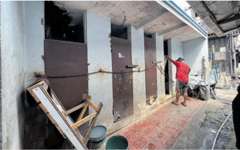
Toiletgebouw op de Filipijnen in aanbouw. Foto: aangeleverd
