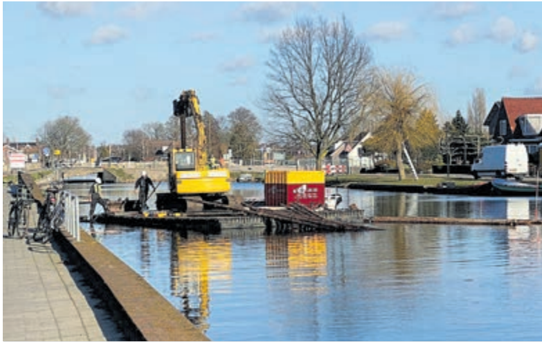
Werkzaamheden aan de kop van het Stokkeland. Foto: www.kicksfotos.nl
