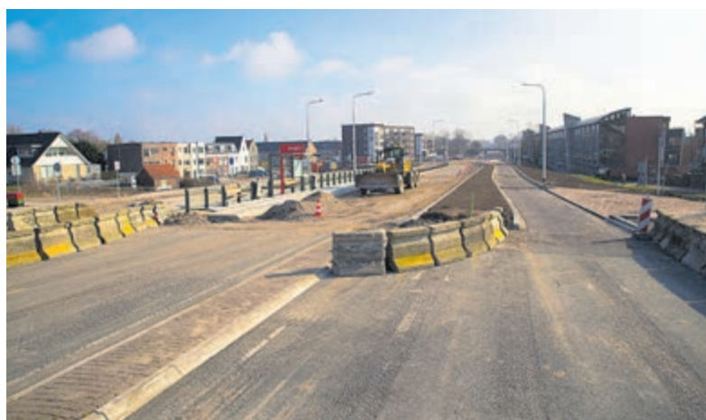
Aanleg bushalte-locatie Centrum nabij de Van Cleeffkade.
