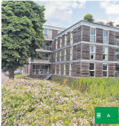
Drie Kolommenplein 93 Aalsmeer
