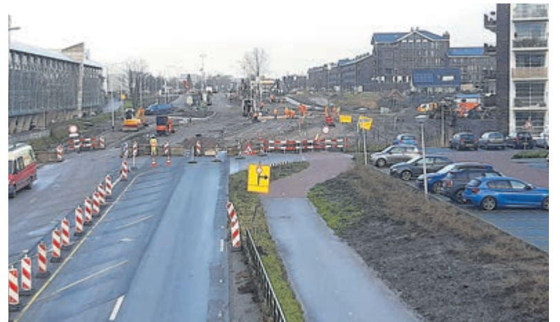
Werkzaamheden voor rotonde bij de Burgemeester Hoffscholteweg.
