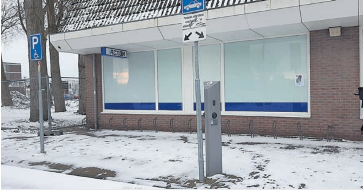
Openbare oplaadpaal voor elektrische auto's op het Drie Kolommenplein.
