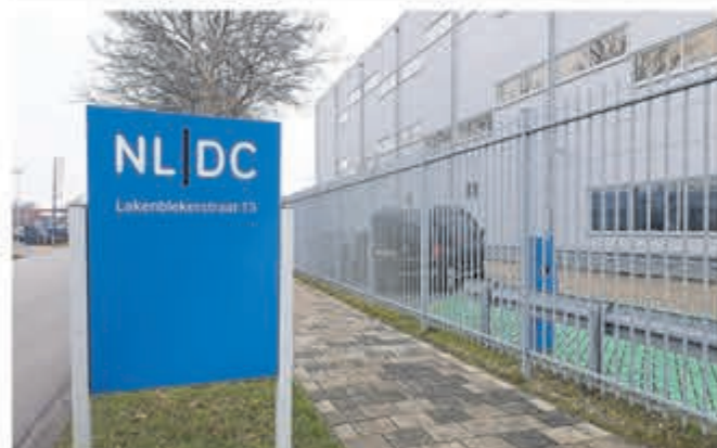
Het Data-centrum NL DC op bedrijventerrein Hornmeer.
