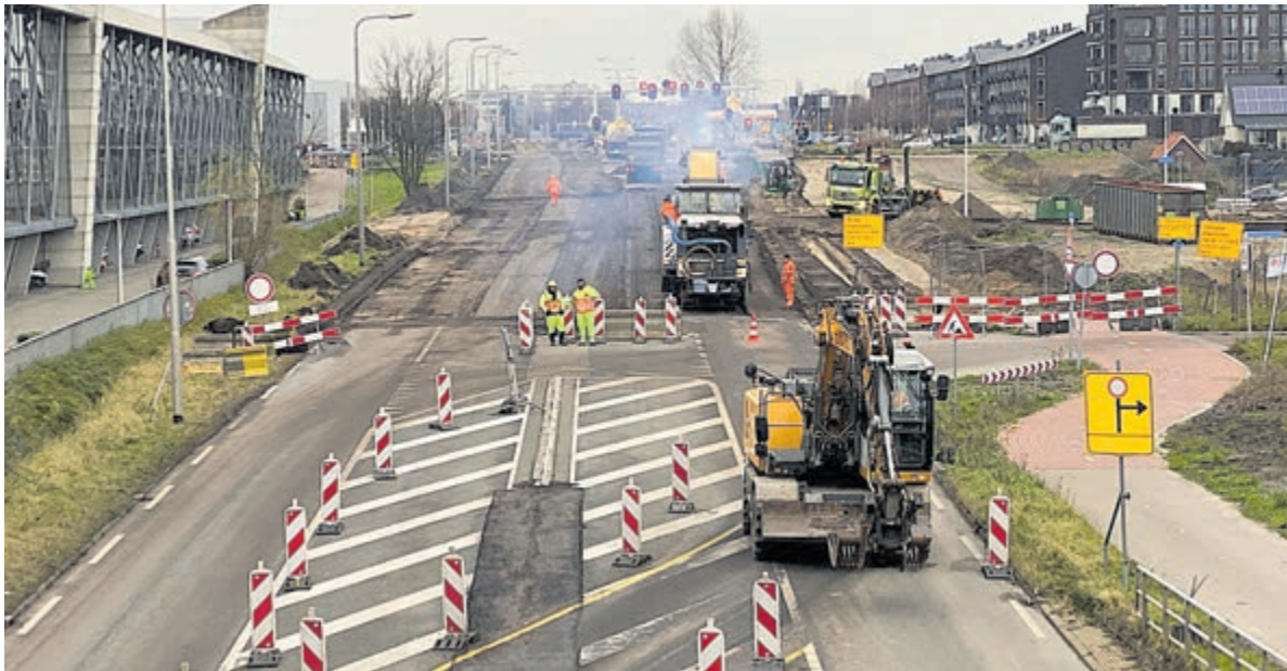
Herinrichting weg en aanleg rotonde bij Hoffscholteweg. Foto: www.kicksfotos.nl
