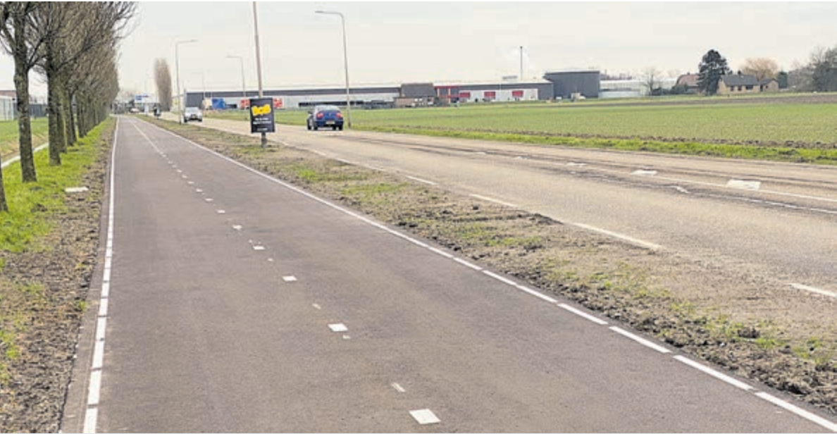
Het fietspad langs de Ambachtsheerweg is al voorzien van een nieuwe asfaltlaag. Nu de rijbaan nog. Foto: www.kicksfotos.nl
