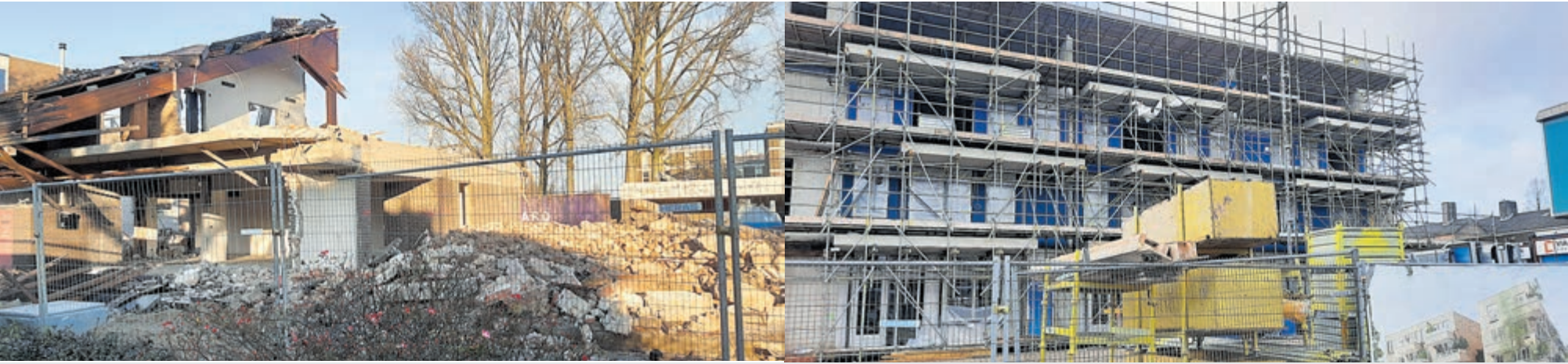
In februari ging de eerste paal de grond in voor de Posterijen. Aan de Stationsweg verrijzen 28 appartementen. De verwachting is dat de nieuwe bewoners eind dit jaar hun woning kunnen betrekken.
