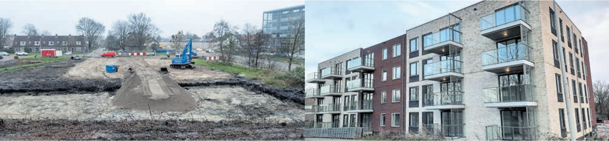
In februari is een start gemaakt met de bouw van 44 appartementen in het Laurierhof en inmiddels is het complex bij het Baanvak en de Spoorlaan bijna voltooid.
