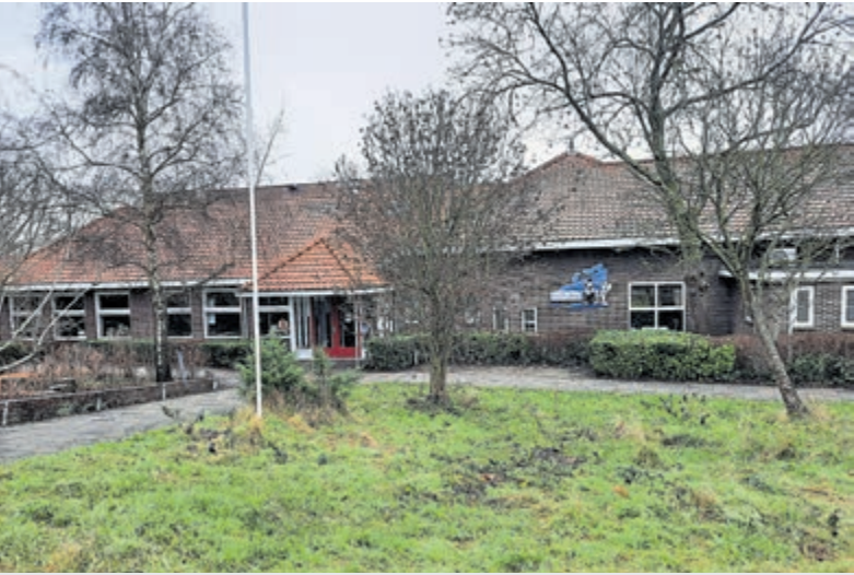
Tijdelijke lokalen gaan vervangen worden voor nieuwbouw bij de Jozefschool.
