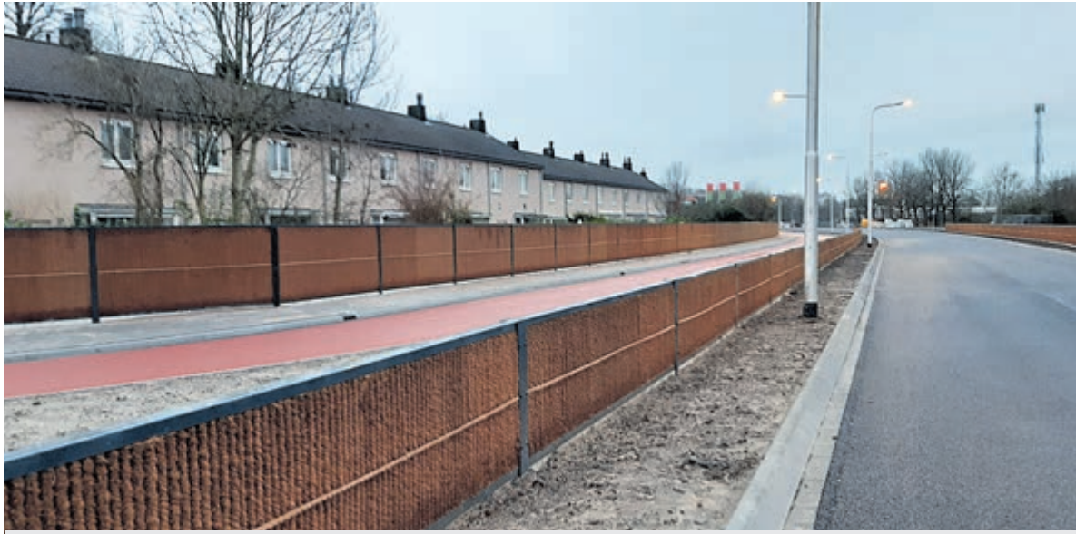
De natuurlijke geluidsschermen langs de Burgemeester Kasteleinweg bij de tot fietsstraat omgetoverde Witteweg. In het midden de toekomstige busbaan.
