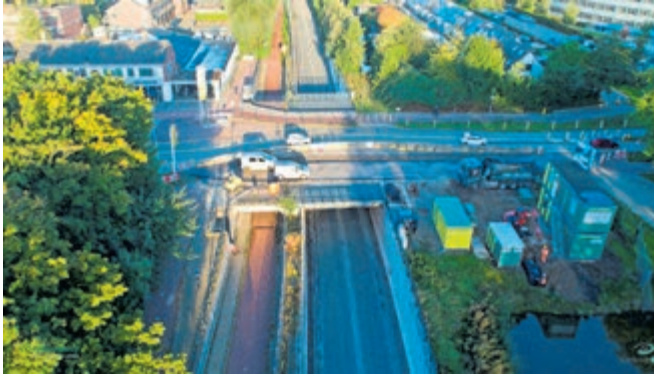
Op de Zijdelweg geldt een om-en-om-regeling, zodat verkeer doorgang vindt langs de werkzaamheden
