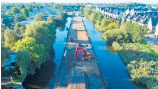
Op het rechte deel van de spoordijk vinden deze maand veel grondwerkzaamheden plaats
