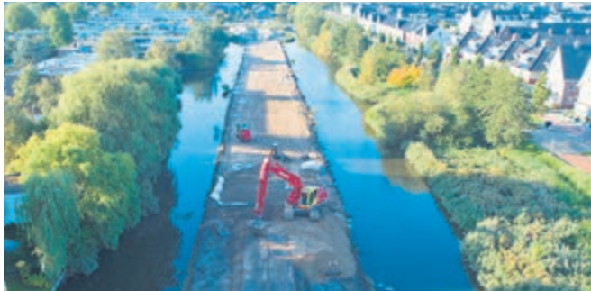
Op het rechte deel van de spoordijk vinden deze maand veel grondwerkzaamheden plaats
