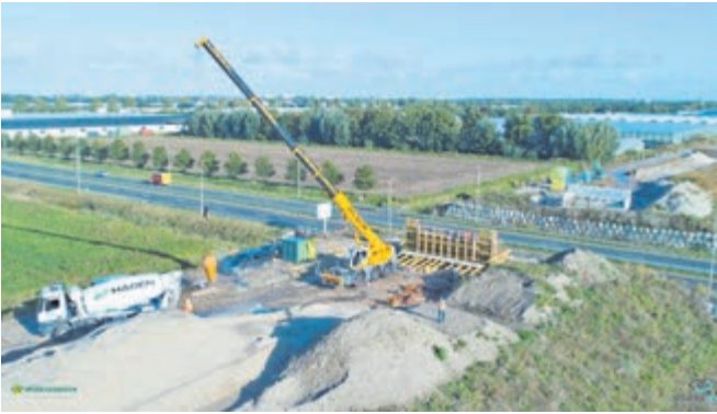
De voorbereidingen voor het inhijzen van de eerste viaductdelen is in volle gang
