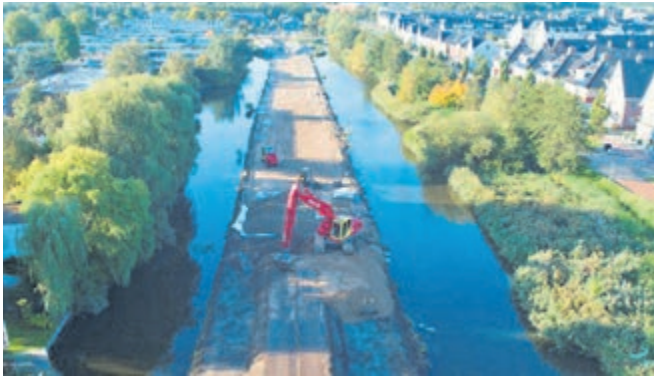
Op het rechte deel van de spoordijk vinden komende maand veel grondwerkzaamheden plaats
