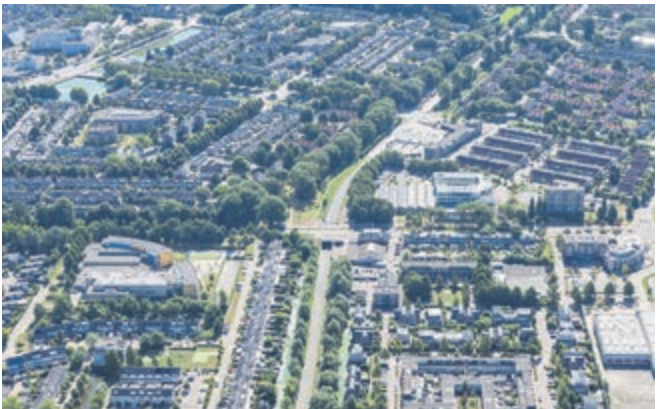
Het viaduct Zijdelweg over de bestaande busbaan, met op de achtergrond het busstation.
