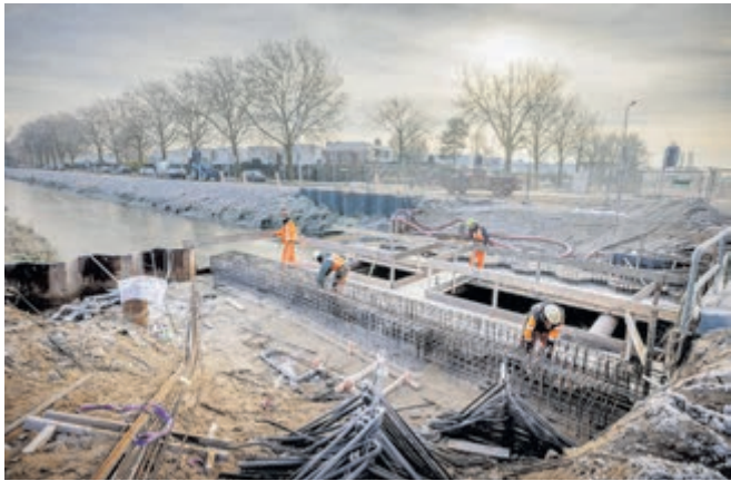
Nabij de Randweg komt een nieuwe brug over de Hoofdtocht
