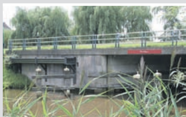
Gereedliggende buizen om tussen de muren van de brug een dam op te werpen in de Ringvaart
