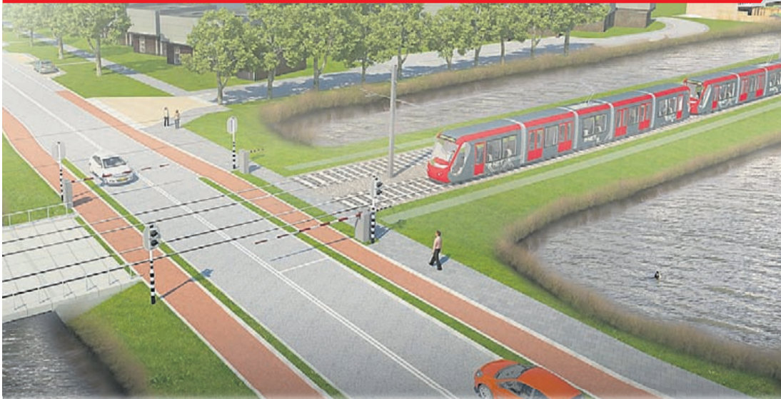
Met verkeerslichten beveiligde kruising trambaan bij de Randweg
