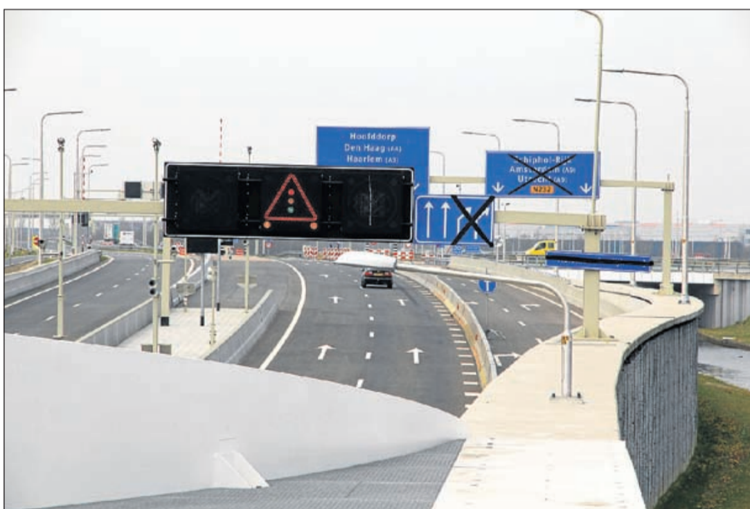
Bij de uitrit van de Waterwolftunnel is de afslag rechts naar Schiphol-Oost en de A9 afgesloten.
